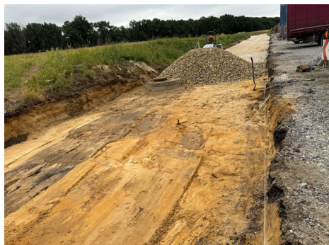
Przebudowa ul. Dąbrowy w Bluszczowie
