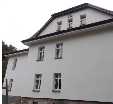
Elewacja budynku wielorodzinnego przy ul. Leśnej
