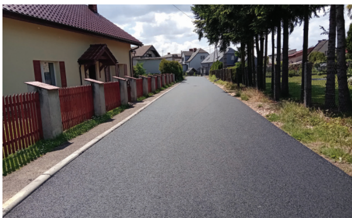
Olza, ul. Zwycięstwa przebudowana z kanalizacją sanitarną Fot.: UG
