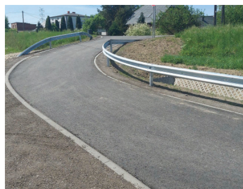
Bełsznica, odnoga ul. Stawowej po przebudowie Fot.: UG
