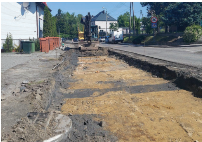
Rogów, ul. Raciborska w przebudowie Fot.: UG
