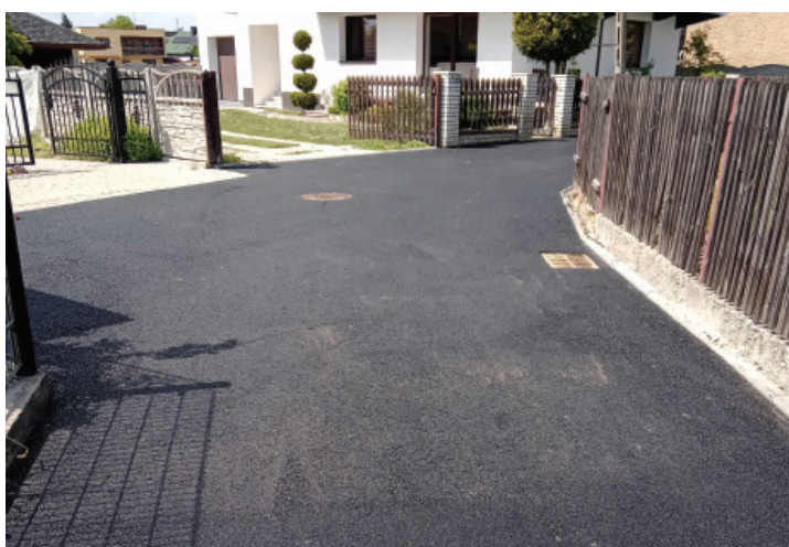
Olza, ul. Stawowa przebudowana z kanalizacją sanitarną Fot.: UG
