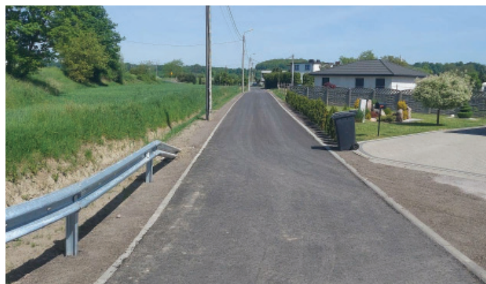
Bełsznica, odnoga ul. Stawowej po przebudowie Fot.: UG
