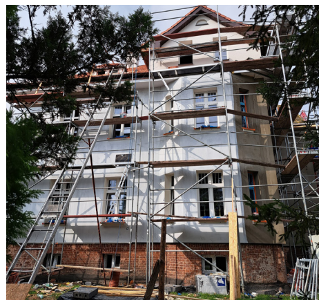
Budynek wielorodzinny przy ul. Leśnej 44
