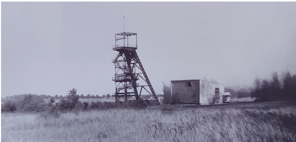
Kopalnia „Czyżowice”, budynek maszyny wyciągowej i wieża szybu III
