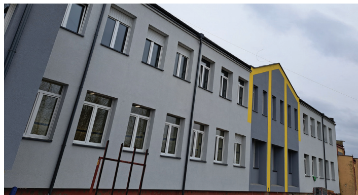
Cały budynek ZSP w Turzy Śląskiej w trakcie termomodernizacji
