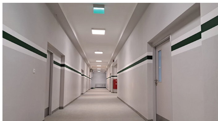
Korytarze również zostają wyremontowane
