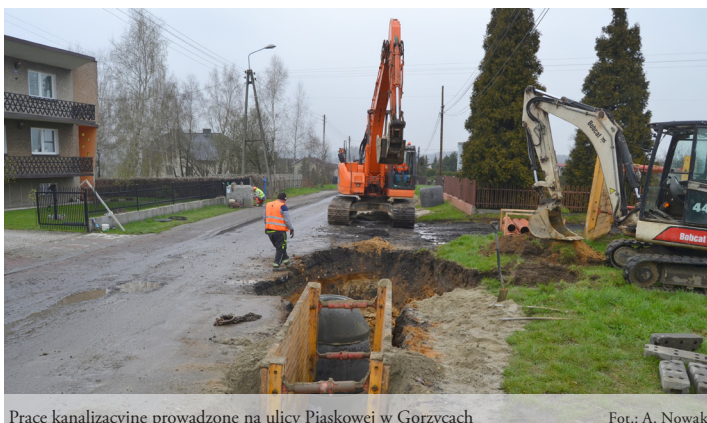
Prace kanalizacyjne prowadzone na ulicy Piaskowej w Gorzycach.
