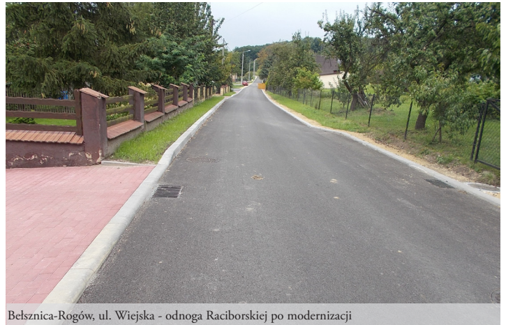
Belsznica-Rogów, ul. Wiejska - odnoga Raciborskiej po modernizacji
