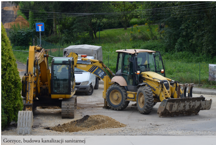
Gorzyce, budowa kanalizacji sanitarnej
