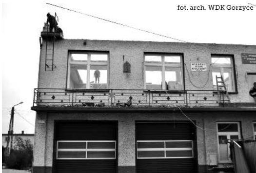
Remontowany budynek WDK w Gorzycach
