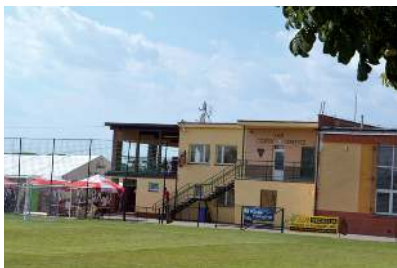
Ukończona rozbudowa sali gimnastycznej w Gorzycach.
