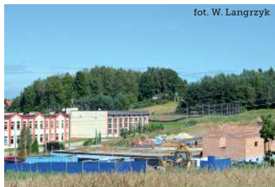
Budowa Przedszkola w Turzy Śląskiej.
