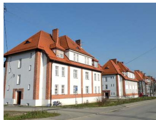
Kolejny wyremontowany familok na Koloni Fryderyk.
