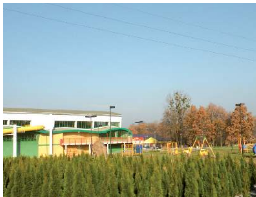
Budowa placu zabaw przy "Nautice" w Gorzycach.
