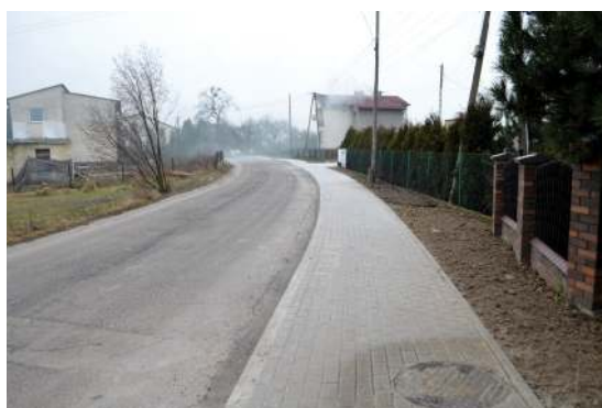
Chodnik przy ul. Wyzwolenia
