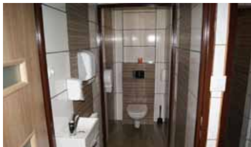
Nowo weromontowane pomieszczenia OSP Gorzycy
